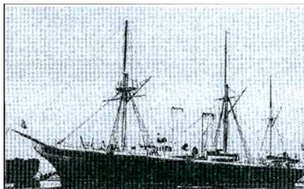
Самое быстроходное военное судно в мире, обводы корпуса которого были разработаны Фрудом в 1875 г.
