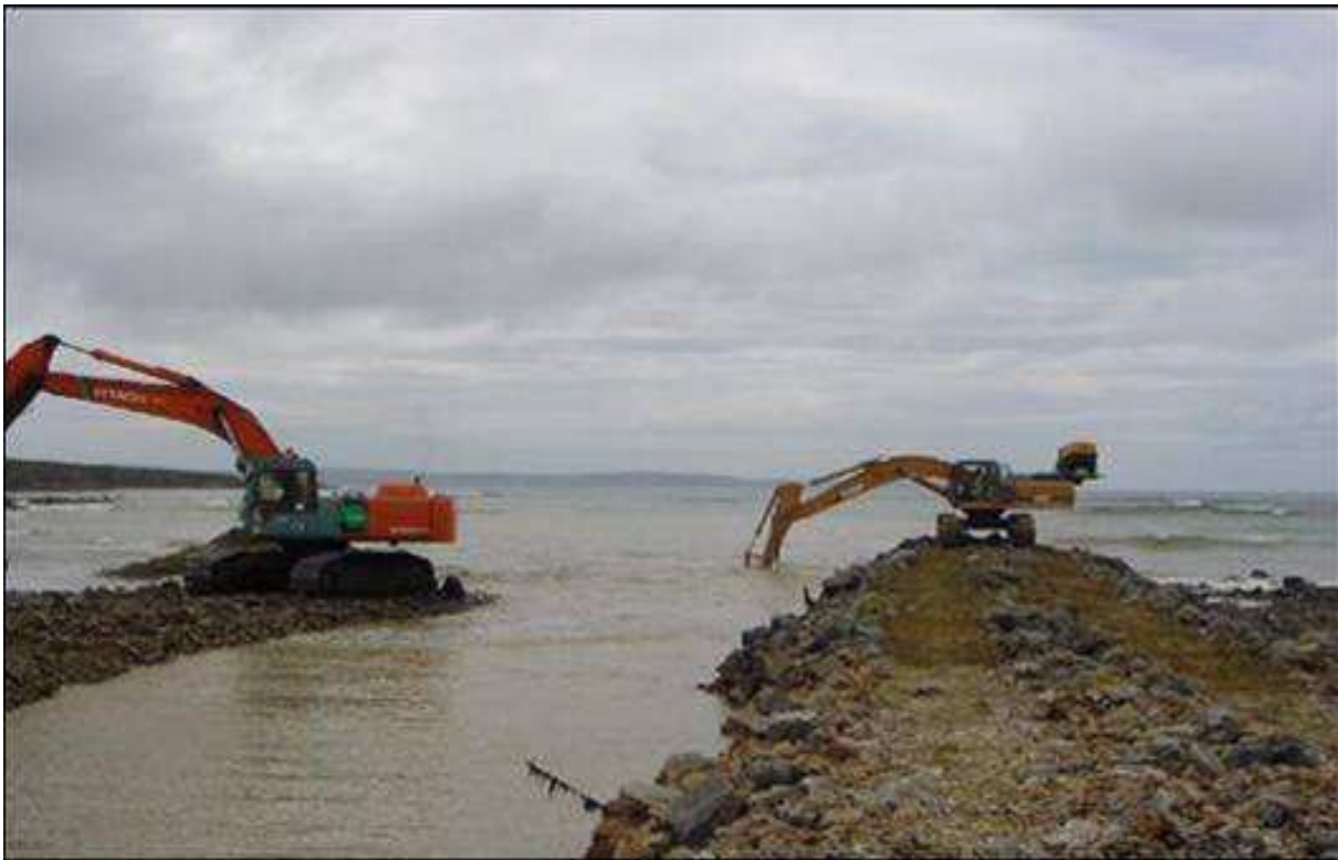
Рис. 1. Разработка траншеи с дамбы на участке пересечения береговой линии.
