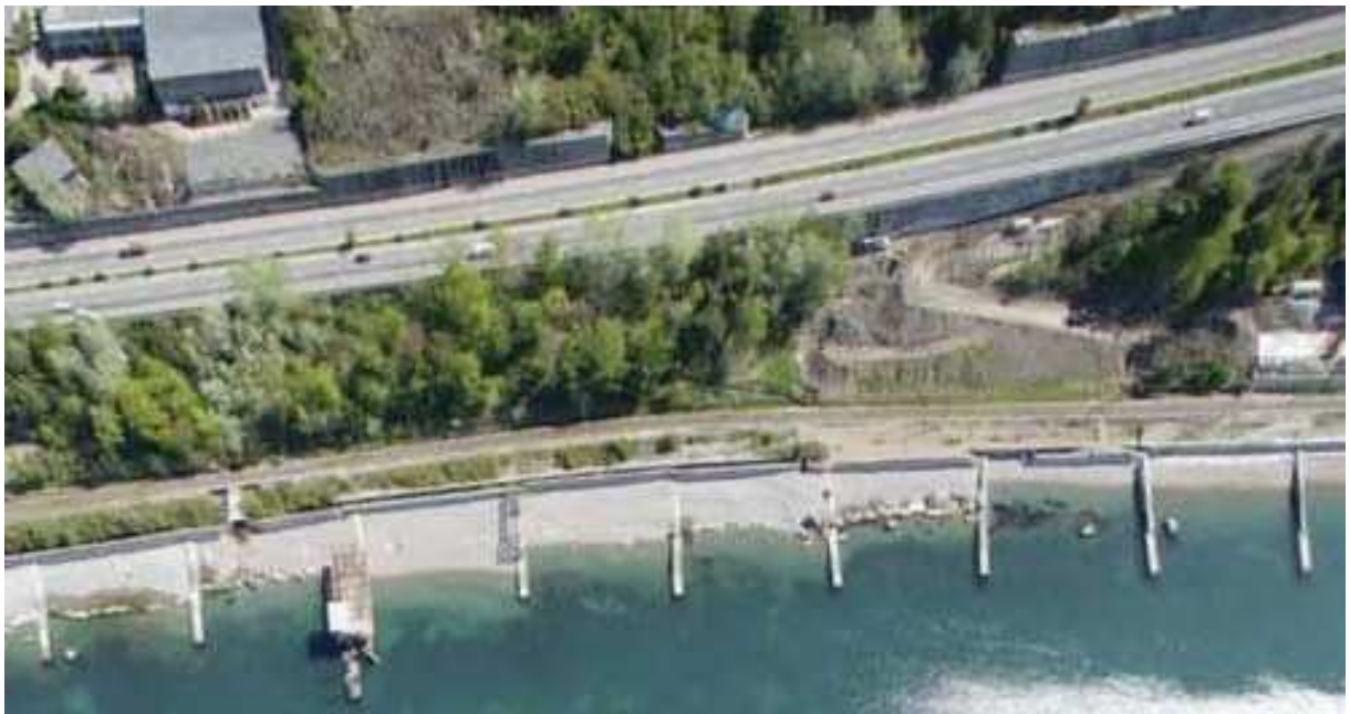
Рис. 4. Буны на участке строительства [3].
